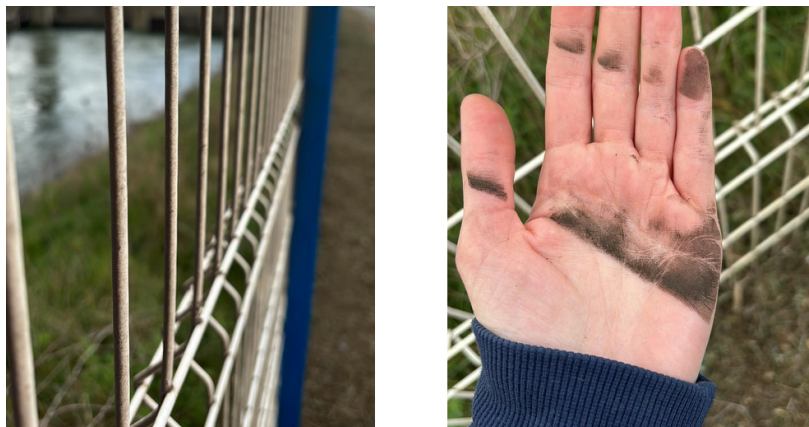
FIGURE 9 : dépôt de poussières noires sur le grillage, au point de mesure PTO3
